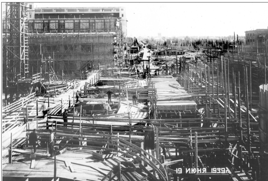
На строительстве отбельного цеха АЦБК. 1938 г.
