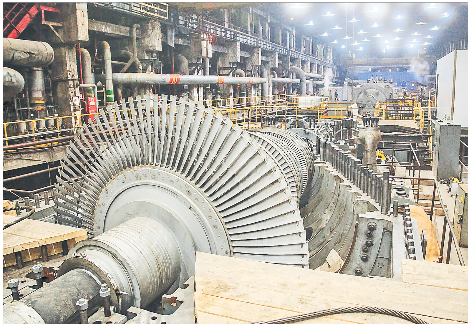
МОНТАЖ турбоагрегата №7 в турбинном цехе первой теплоэлектростанции АЦБК
